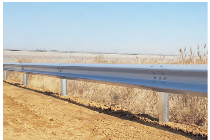
성토부 노측용 SB2등급 [JD-SGS-SB2-UE] / W4000 x H775 (mm)
