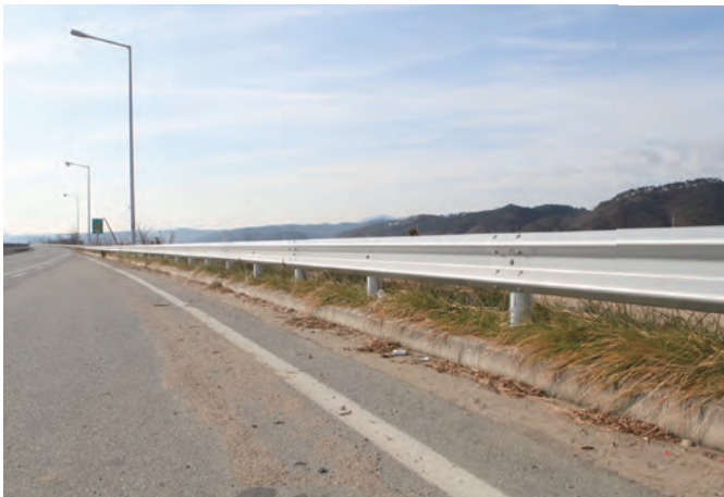
성토부 노측용 SB4등급 [JD-SGS-SB4-E] / W2000 x H775 (mm)
