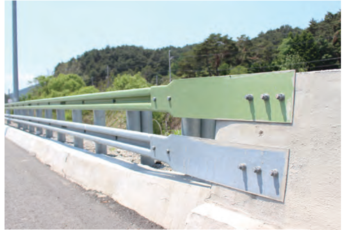
성토부 노측용 전이구간 SB4등급 [OGS-SB4-EJ-A] / W12000 x H900 (mm)
