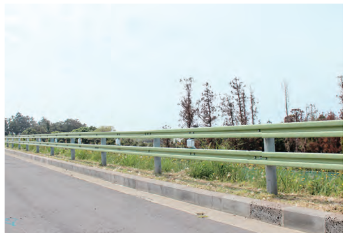
평지부 노측용 SB2등급 [OG-SB2] / W3000 x H900 (mm)
