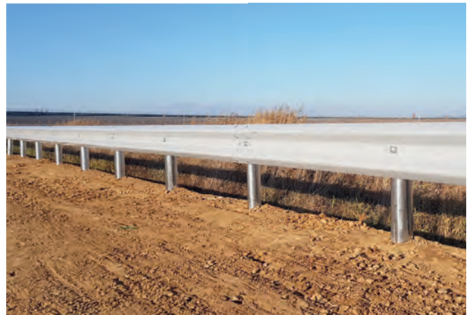
성토부 노측용 SB4등급 [JD-SGS-SB4-UE] / W2000 x H775 (mm)
