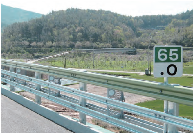
평지부 노측용 SB5등급 [SB-08-04] / W3000 x H1100 (mm)
