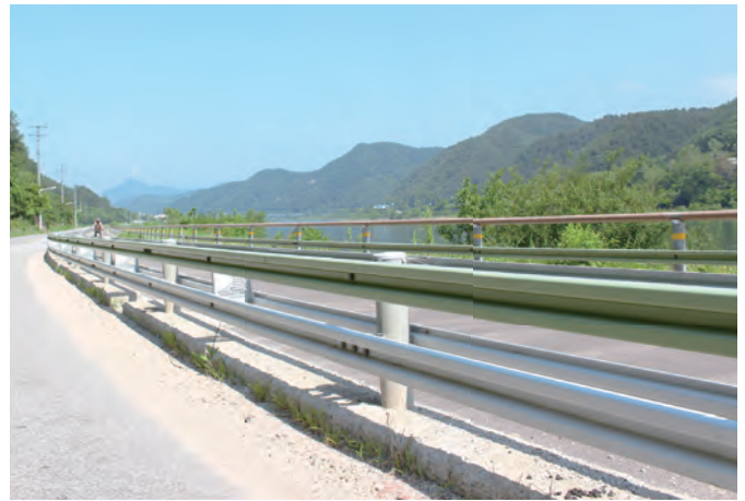
평지부 노측용 SB4등급 [OG-SB4] / W3000 x H900 (mm)
