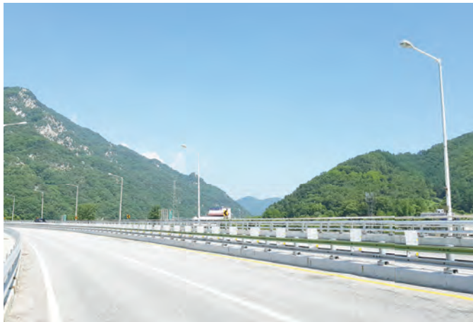
중앙분리대용 SB5등급 [AC-SB5] / W2000 x H870 (mm)
