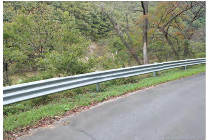
성토부 노측용 SB1등급 [JD-EX-SB1] / W4000 x H810 (mm)
