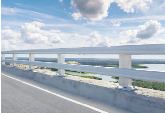
알루미늄제 교량난간 SB4등급 [ALB-SB4-A] / W2000 x H850 (mm)
