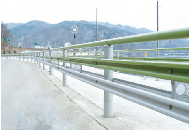
평지부 노측용 SB2등급 [OG-SB2-C] / W3000 x H1200 (mm)
