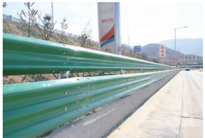
성토부 노측용 SB5등급 [JD-EX-SB5] / W2000 x H1210 (mm)
