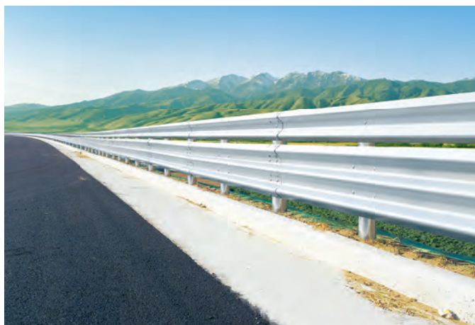
성토부 노측용 SB5-B등급 [SGS-SB5B-A] / W2000 x H1210 (mm)
