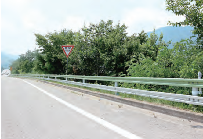
성토부 노측용 SB4등급 [OGS-SB4-A] / W2000 x H850 (mm)
