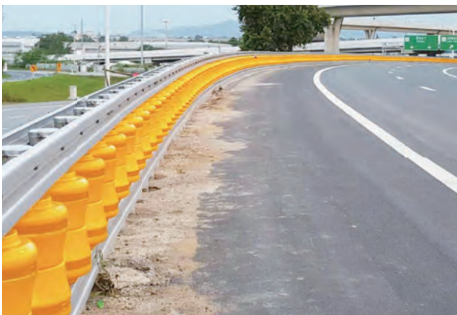
성토부 노측용 SB5등급 [RGS-SB5-S1] / W700 x H1000 (mm)
