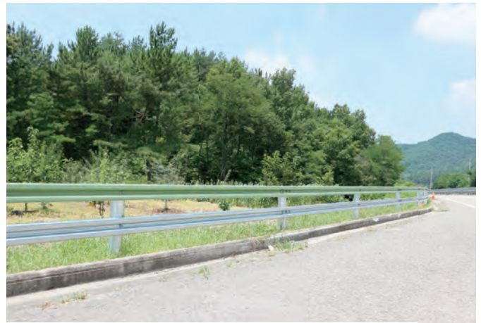
성토부 노측용 SB2등급 [OGS-SB2-A] / W3000 x H850 (mm)
