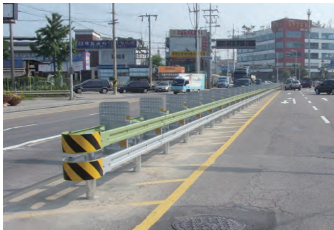
중량분리대용 SB5등급 [SB-05-08] / W2000 x H850 (mm)
