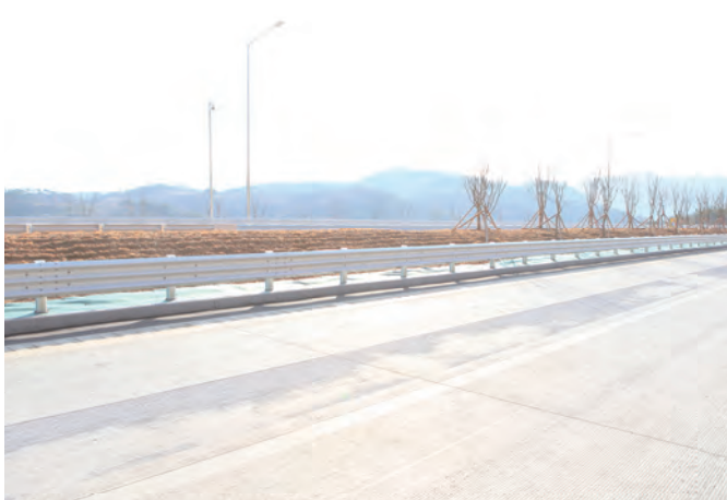
성토부 노측용 SB3등급 [JD-EX-SB3] / W2000 x H810 (mm)
