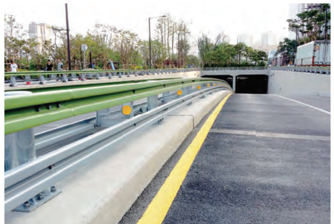
중앙분리대 교량용 SB4등급 [OCB-SB4] / W3000 x H650 (mm)
