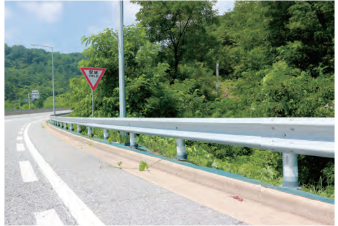
성토부 노측용 SB4등급 [SGS-SB4] / W2000 x H775 (mm)
